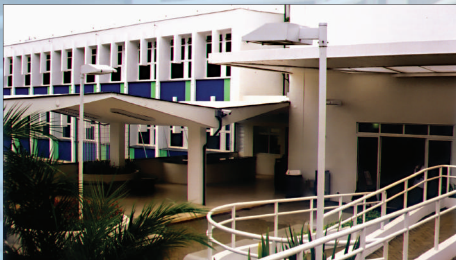
Entrada da APAE/SP, após reforma
