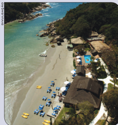
A pousada Ilha do Papagaio aproveita estrutura da ilha e minimiza impactos ambientais
