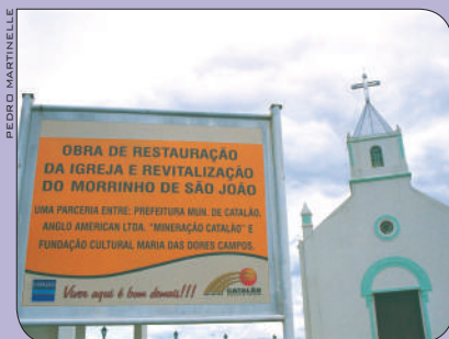
Obra de restauração de igreja de Catalão patrocinada pela Anglo American e Mineração Catalão
